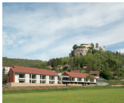
Maison d'accueil et de résidence pour l'autonomie à Ornans
